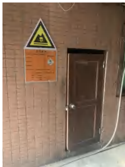
禺南食品厂危废贮存仓 GF - 禺南食品厂
