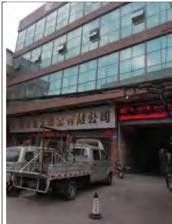
建筑物外观照片
