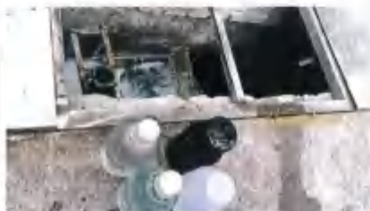
废水：污水处理站处理后（WS-04881）
