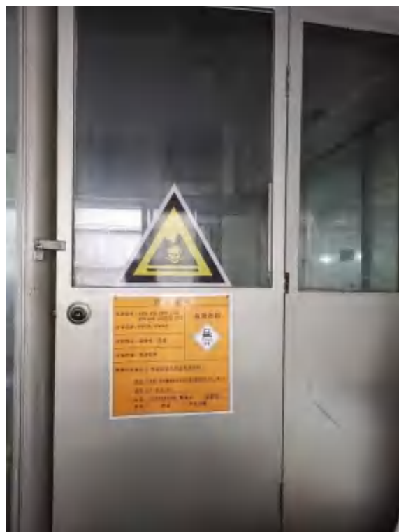
广州锐讯塑料制品有限公司 危废贮存仓 GF-锐讯-01
